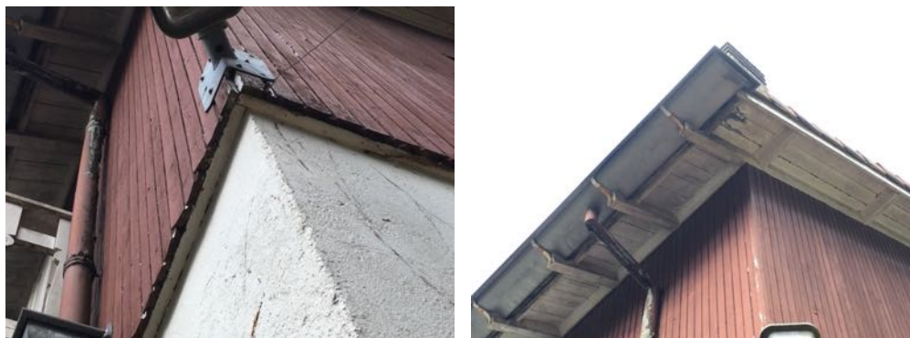
Figuur 10 & 11. Aansluiting voorschot op gevel met de onderzijde (l) en de bovenzijde.
