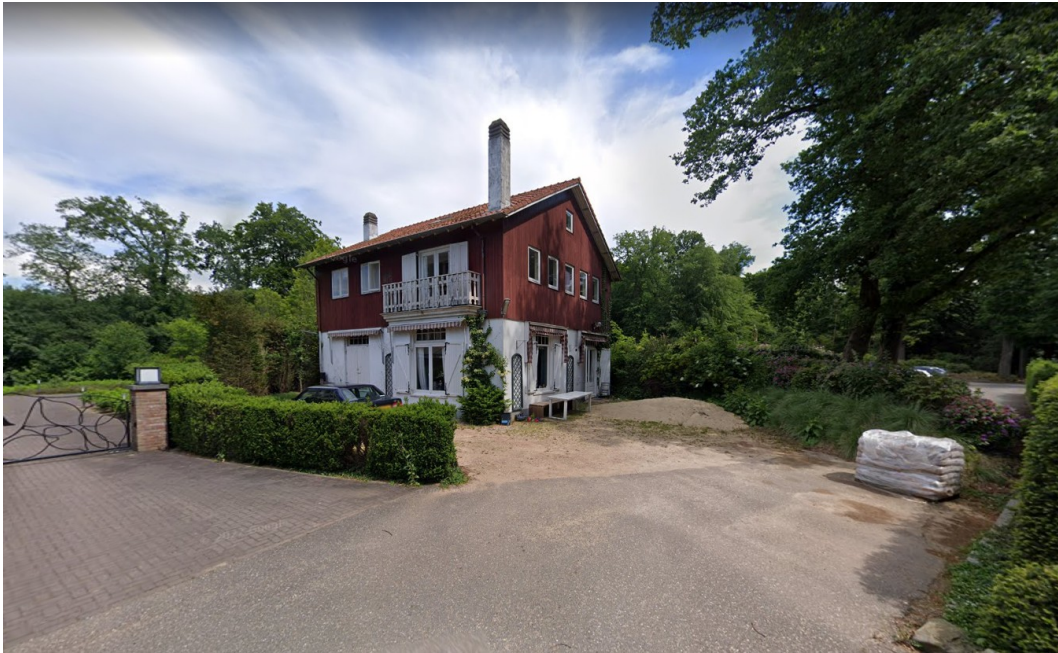
Figuur 8: Foto kijkend naar het plangebied in noordoostelijke richting (Google Street View).
