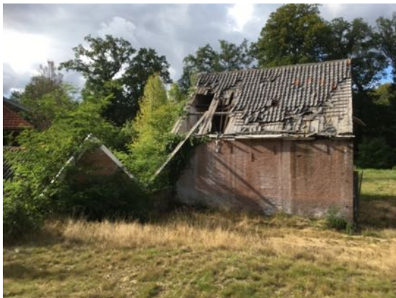
Figuur 5. Zuidgevel van de schuur met links de kap van de wijnkelder.
