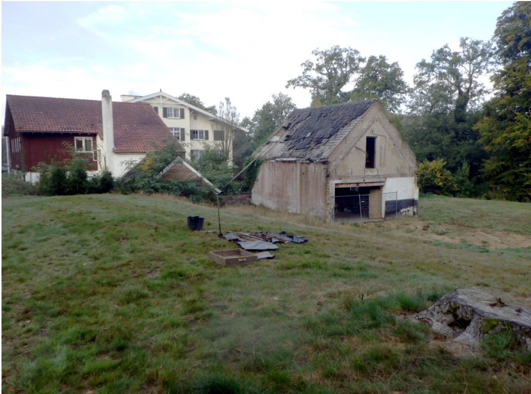
Figuur 33: Foto kijkend naar het westen, naar de locatie van boorpunt 5 waar op het AHN een ronde terreinverhoging zichtbaar is van circa 150 cm (vergelijk met figuur 14).
