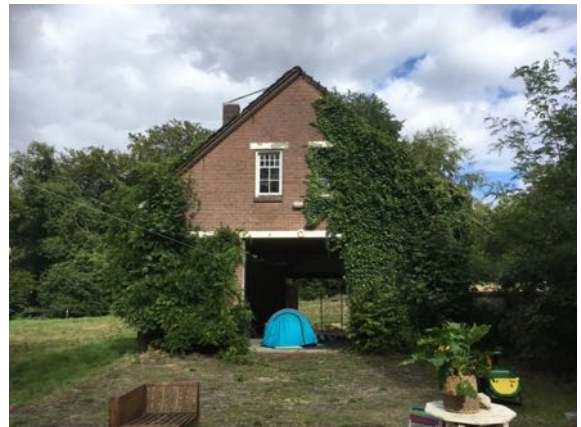
Figuur 4. Westgevel van de schuur.
